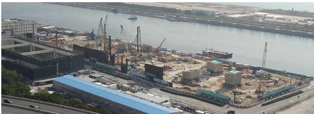
位于启德发展区的香港儿童医院建筑工地（图片来源：医院管理局）
